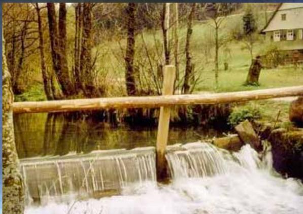
Das Mühlewehr an der Kinzig wurde früher zum Ableiten von Wasser in den Mühlkanal genutzt. Über eine Stellfalle mit Gewinde und Kurbel konnte der Zulauf in den Kanal geöffnet werden.
