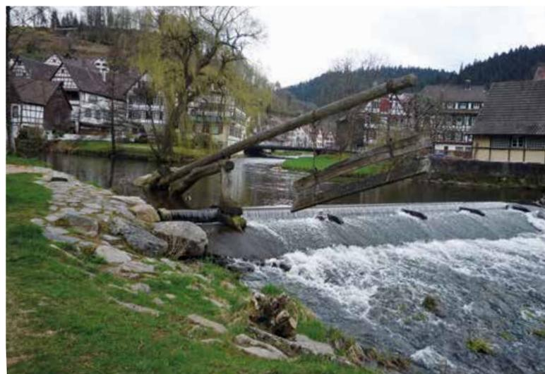
Als weitere Möglichkeit zum Öffnen der Wehre gab es Gamber wie hier in Schiltach, welche nur im Kinzigal gebaut wurden. Der am Drehpunkt gelagerte Stamm, an dem die Sperrtafel befestigt ist, kann gehoben, gesenkt und um 90 Grad gedreht werden. Durch die optimale Gewichtsverteilung war dafür nur ein Flößer notwendig. So konnte das Floß schnell hindurchfahren wenn das Kommando „Gamber uff!“ ertönte.
